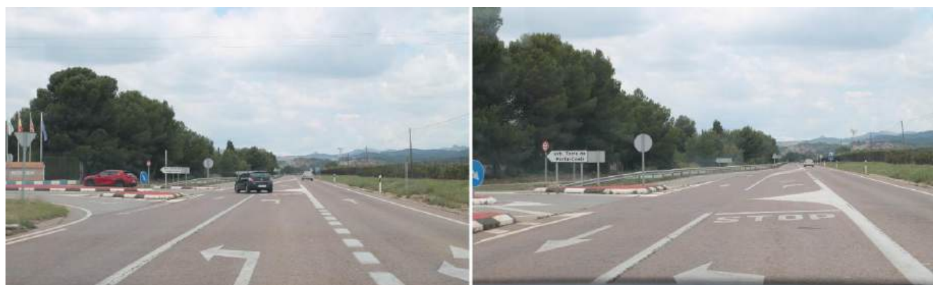
Entrada a la urbanització des de la carretera CV-333
