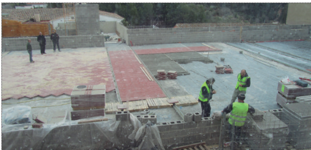
Nueva plaza pública en Serra, donde se ubicaban las antiguas escuelas.
